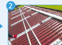
2 横ラック取付け
