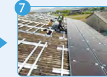
7 パネル取付け
