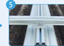
5 横ラック設置
