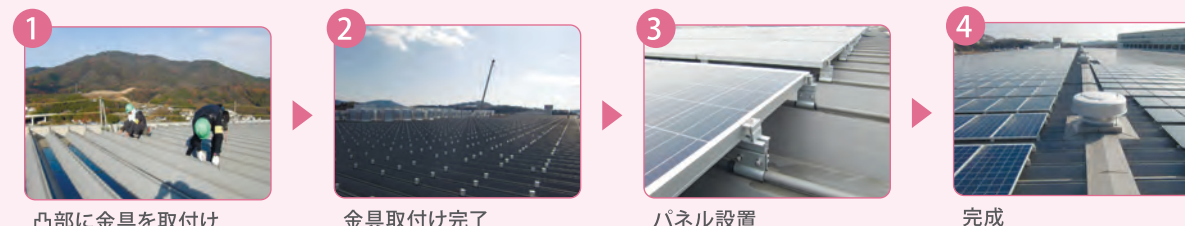
凸部に金具を取付け
