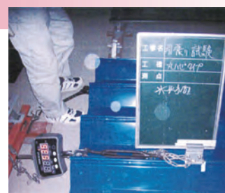
水平荷重試験状況(ハゼ水平方向)
