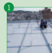
ベースレール設置
