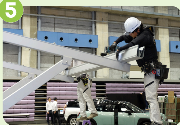
架台組み立て
