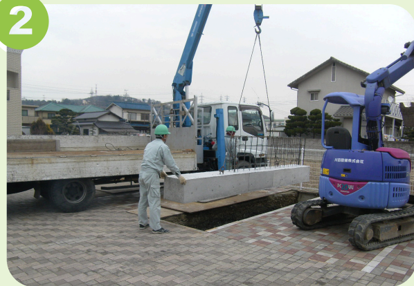
地中梁の設置
