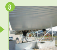
屋根材を下部から取付け
