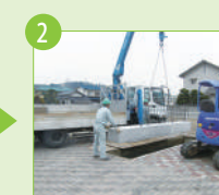
地中梁の設置
