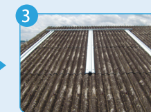
波平設置完了
