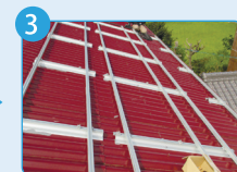
横ラック取付け完了
