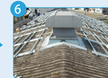
架台設置完了
