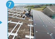
パネル取付け
