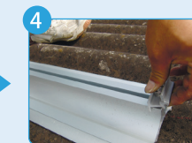
接続金具取付け
