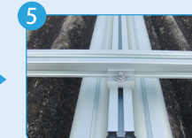
横ラック設置
